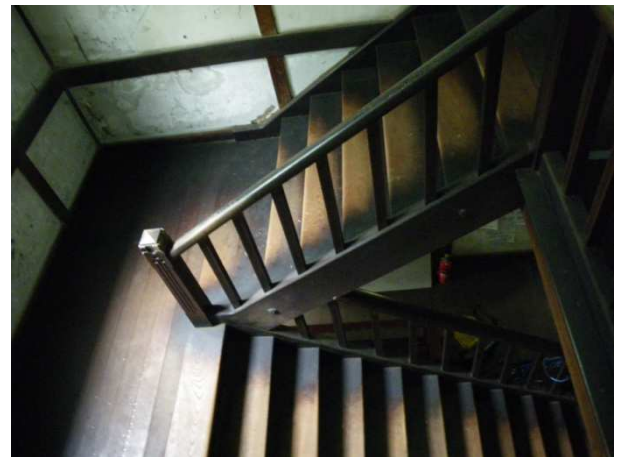
写真 10 吉田寮舎南寮東階段室 2)
