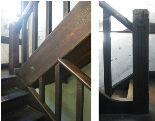
写真 11 吉田寮舎北寮西階段手摺 2)
