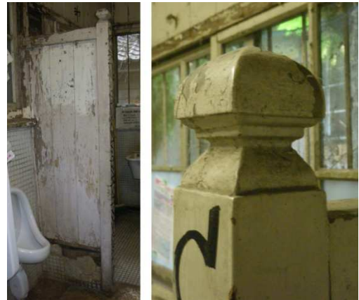
写真8 吉田寮便所内間仕切り壁とその柱頭 2)
