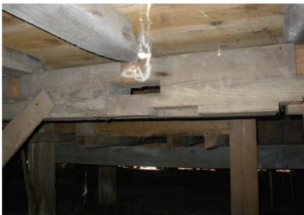
写真 14 吉田寮舎床下調査写真 2)
