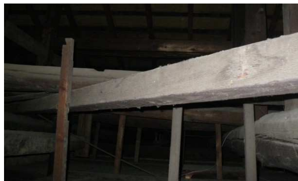
写真 15 吉田寮舎小屋裏調査写真 2)
