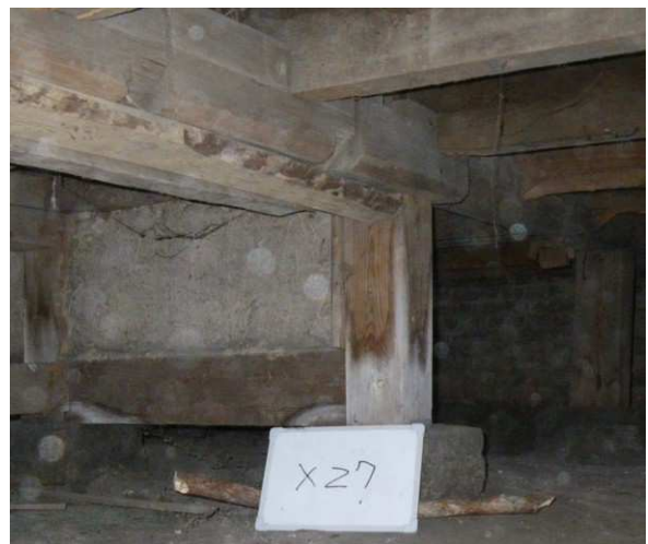
写真 13 吉田寮舎床下調査写真 2)
